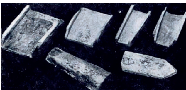
Рис. 5. Виды черепицы, обнаруженной при реставрации Архангельского собора Московского Кремля (по: Меркелова В.Н. К реконструкции фасадов...).
