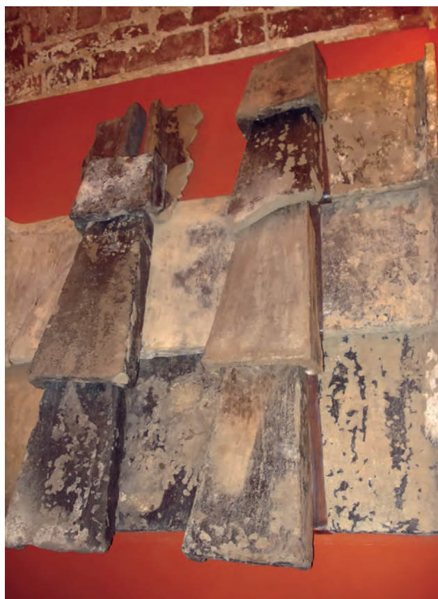
Рис. 10. Натурная реконструкция кровли из черно-лащенной лотковой черепицы XVI–XVII вв. Кириллов Белозерский монастырь, музейная экспозиция.
