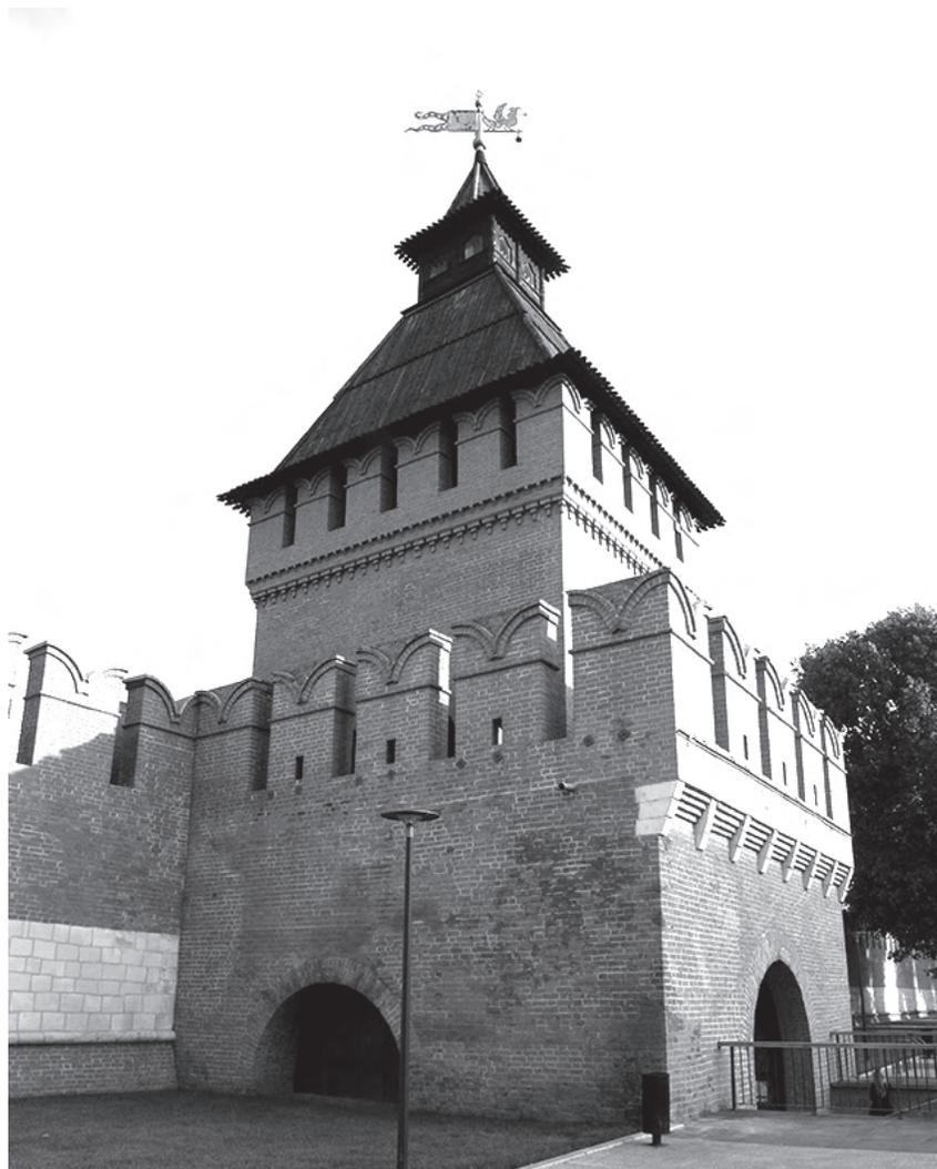
**Илл. 17.** Пятницкая воротная башня. Изначально в ней был устроен Г-образный проезд с ловушкой в середине и круговой галереей на втором ярусе. Слева можно видеть первоначальную воротную арку. Арка справа для прямого проезда была пробита позднее. Фотография автора, 2019 г.
