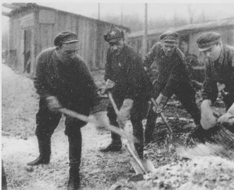
Работы на месте будущего Электророзавода
