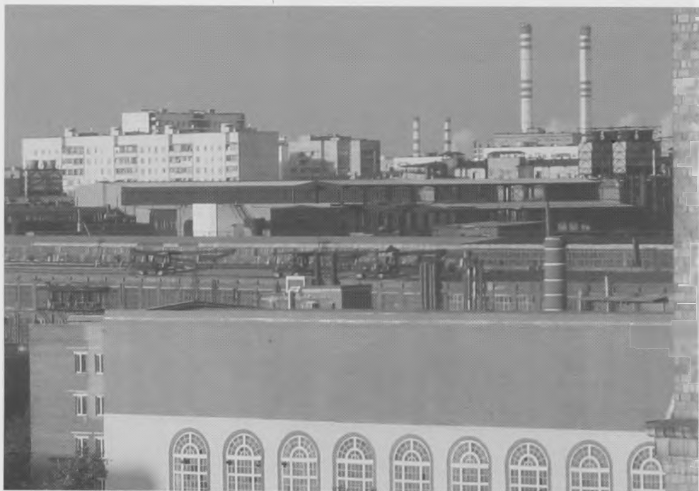
Современный индустриальный пейзаж цехов Электростанции
