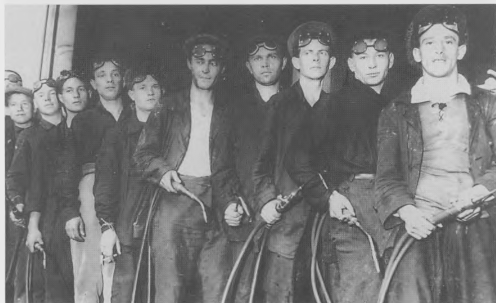
Сварщик — одна из самых дефицитных профессий на Электростанции
