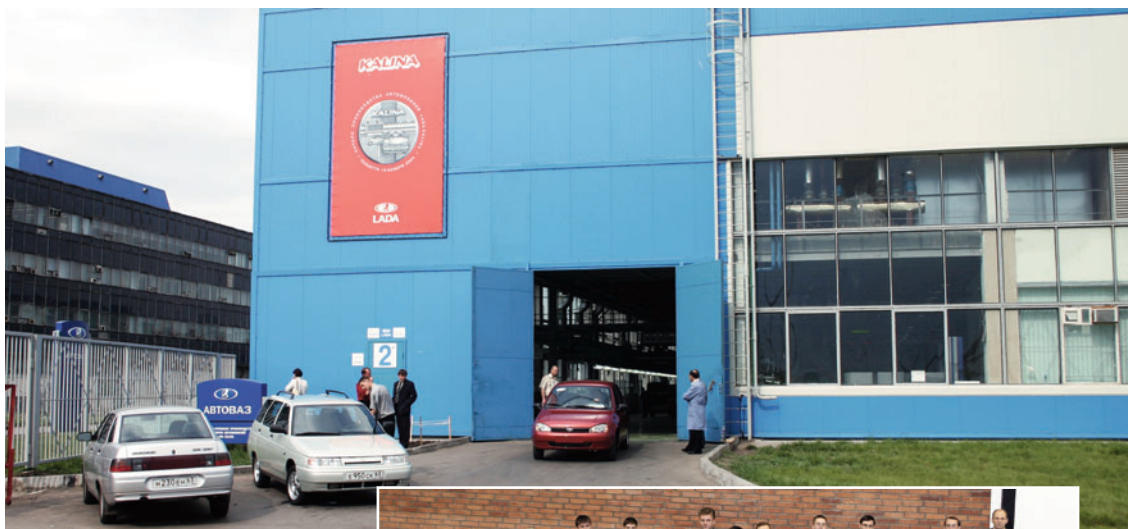
Новый сборочный комплекс по производству автомобилей семейства LADA KALINA.
