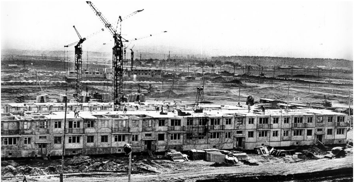
Первый блок в фундамент первого дома уложен в октябре 1967 г.
