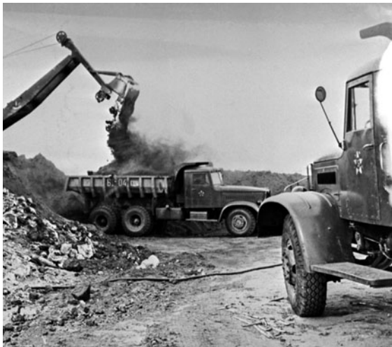
Выемка и перемещение первых кубометров земли на стройплощадке ВАЗа. Разработка грунта на месте будущего строительства главного корпуса автозавода.
