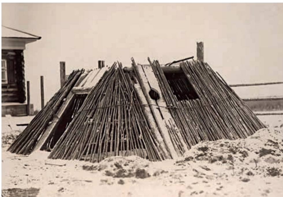
Рис. 2.7. Процесс строительства землянки в с. Ларьякском. 1912 г. Дмитриев-Садовников Г. М. 1912 г. ТИАМЗ. ТМ кп 15550/56
