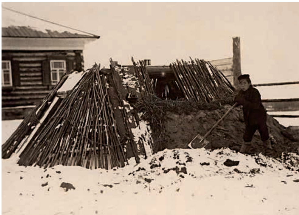
Рис. 2.8. Процесс строительства землянки в с. Ларьякском. 1912 г. Дмитриев-Садовников Г. М. 1912 г. ТИАМЗ. ТМ кп 15550/54
