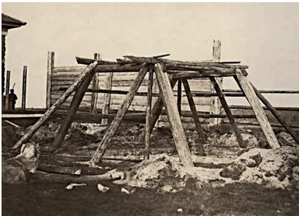
Рис. 2.6. Процесс строительства землянки в с. Ларьякском. 1912 г. Дмитриев-Садовников Г. М. 1912 г. ТИАМЗ. ТМ кп 15550/56
