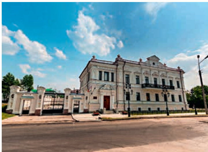
Рис. 5.5. Тобольск. Здание окружного суда. Современный вид
