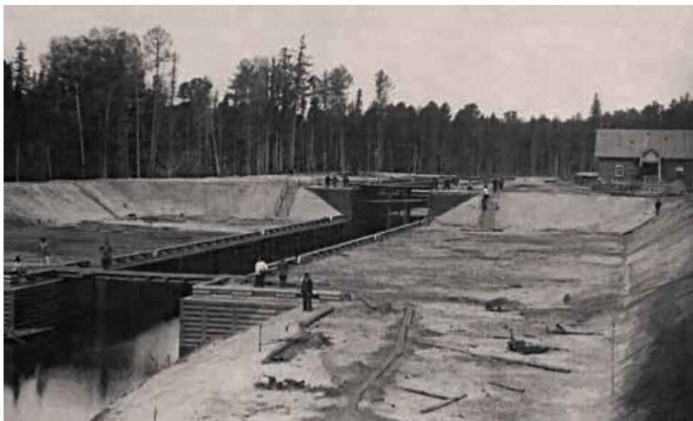
Рис. 3.41. Строительство Обь-Енисейского канала
