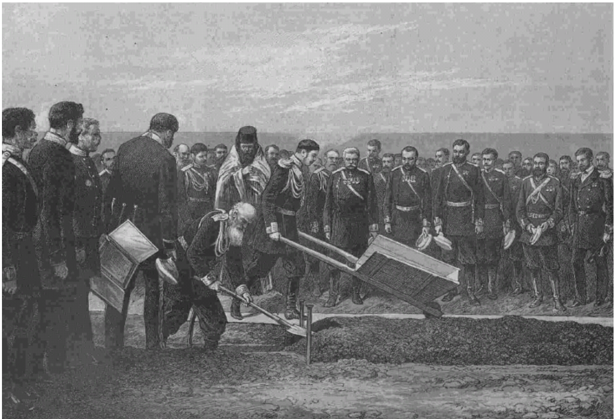
Владивосток. Цесаревич Николай высыпает первую тачку с землей на строительстве железной дороги.
